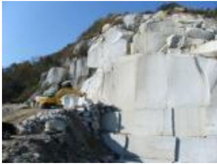
石原石材採石場
